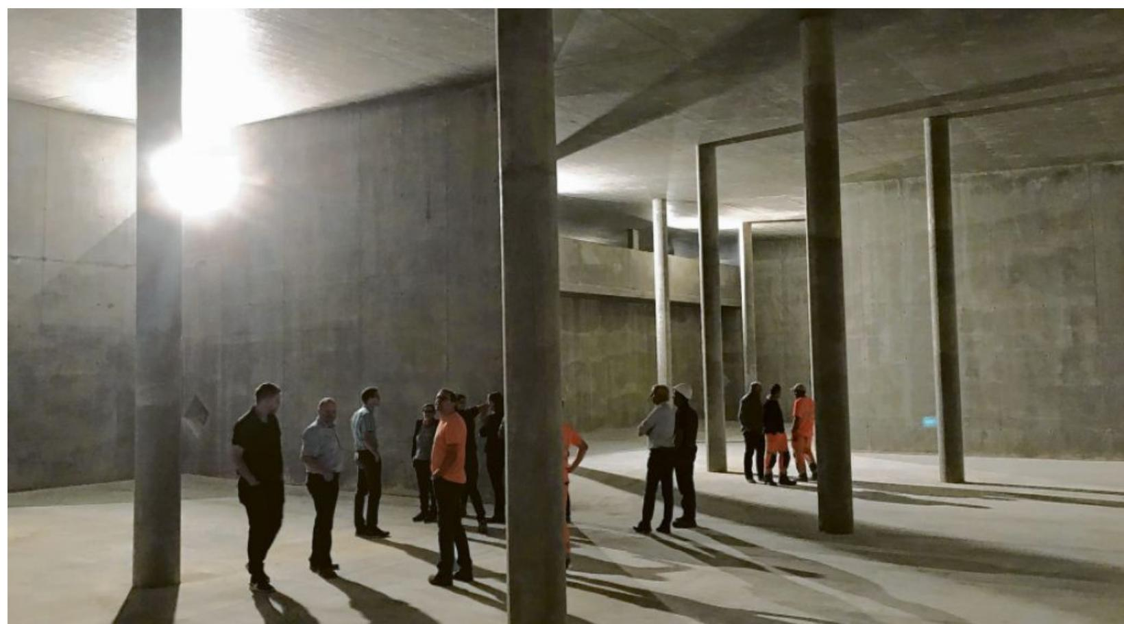
Ein gewaltiges Bauwerk: Die Bayerische Rieswasserversorgung (BRW) errichtet zwischen Herkheim und Ederheim am Riesrand einen neuen Hochbehälter. Dieser fasst einmal 10 000 Kubikmeter Trinkwasser. Der Rohbau ist fertig. Foto: BRW
